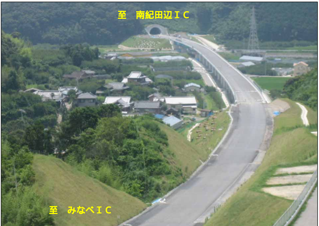
【 芳養高架橋・南紀田辺トンネル付近 平成19年7月18日撮影】
