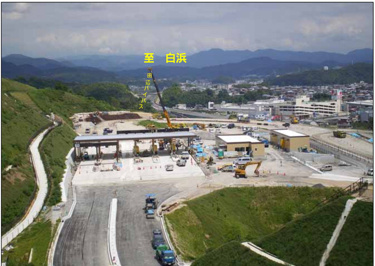
【 南紀田辺IC料金所付近 平成19年7月18日撮影】
