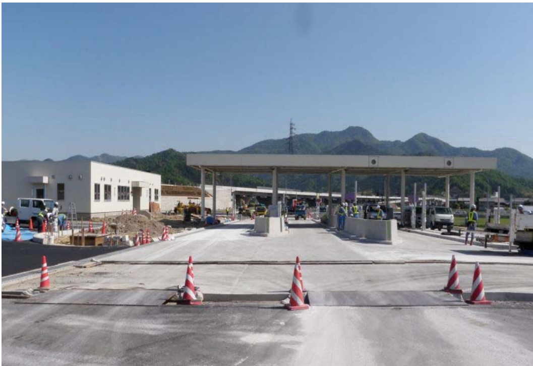
小浜IC(インターチェンジ出口方面)を望む
