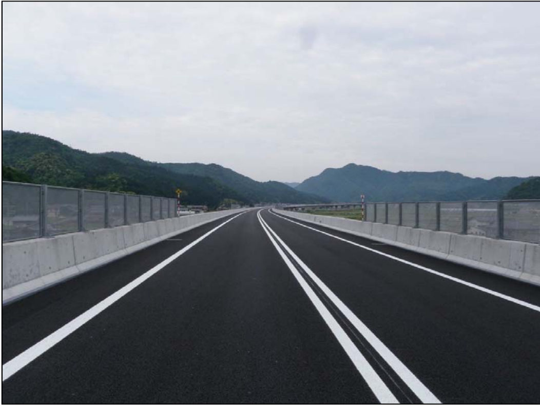
野代(のだい)高架橋(小浜西IC(舞鶴方向))を望む
