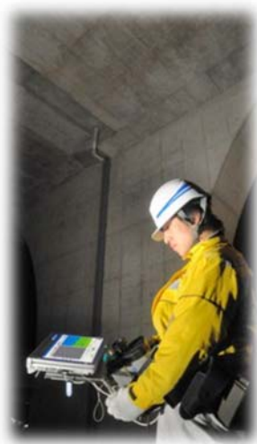
赤外線調査の様子(夜間)
