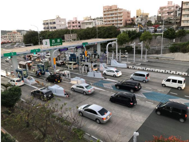
・西原料金所における出口渋滞状況
