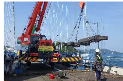
(新)大型伸縮装置の設置作業状況
