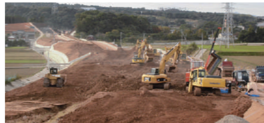
他の建設工事等で発生した土砂を受け入れ、利用しています
