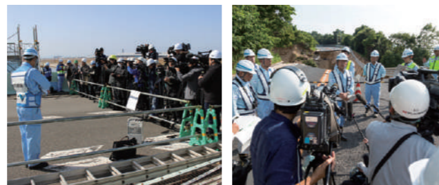
関空連絡橋 橋桁架設マスコミ公開
