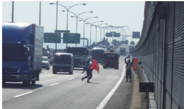
落下物排除の状況
