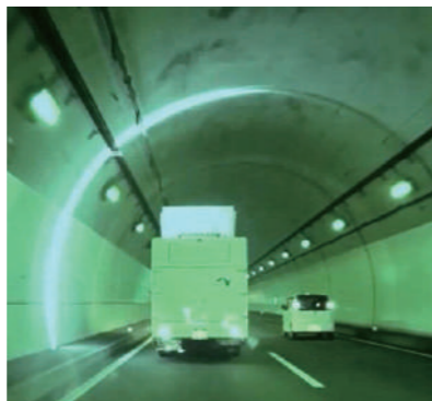
撮影の状況 (赤外線照明による撮影を行うことで、お客さまの運転への影響はありません)
