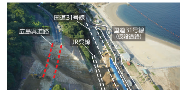
復旧作業の様子
