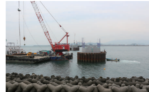
吉野川大橋 工事の様子
