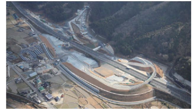
中国自動車道と接続する山崎JCT工事の様子
