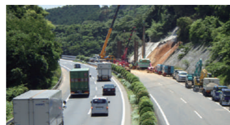
応急復旧の様子
