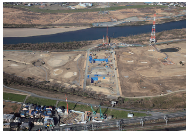
淀川橋 工事の様子
