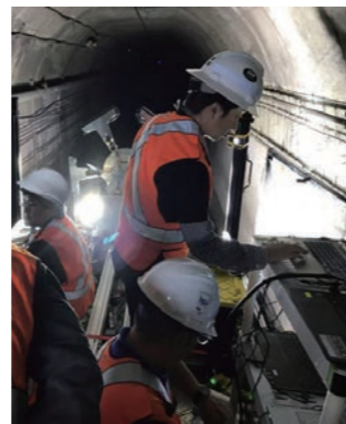
地下鉄トンネル点検 (アメリカ)
