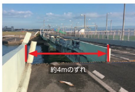
衝突による橋のずれの様子
