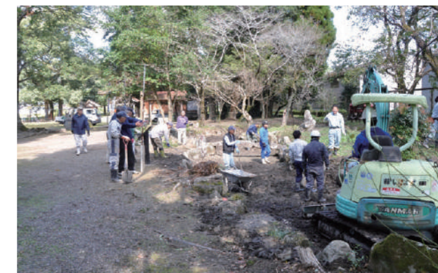
庭園復旧の様子 (西日本高速道路エンジニアリング九州 (株))
