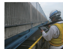
タブレットでの点検記録
