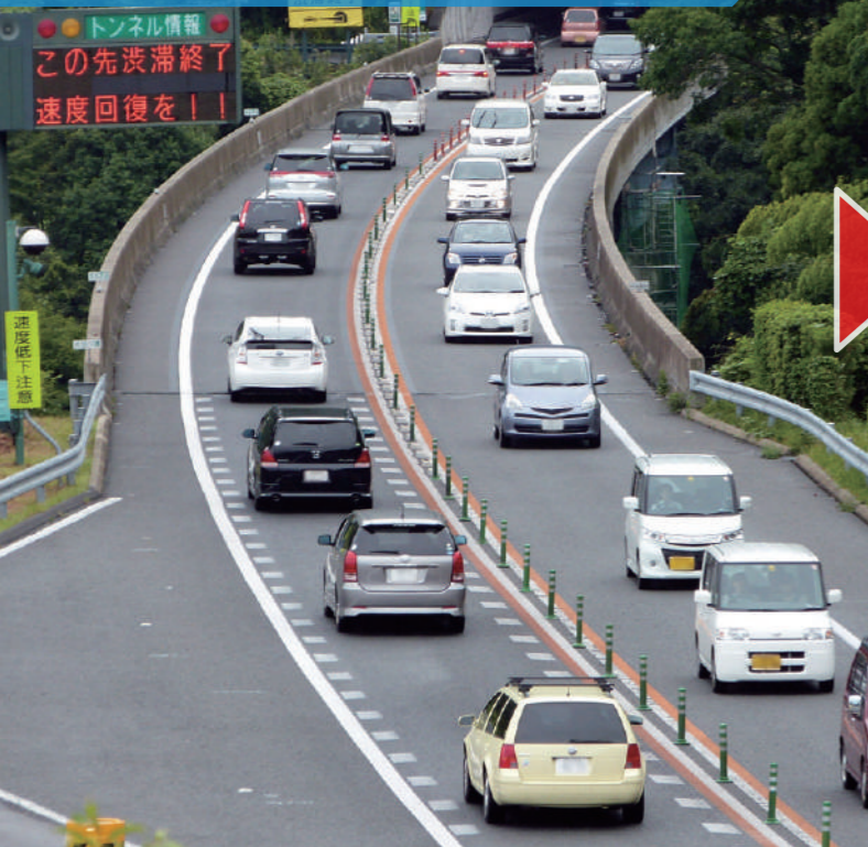
4車線化完了前の状況／高松道(板野IC～引田IC)
