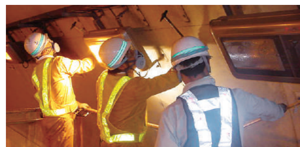
構造物の点検
