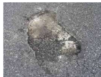
上面 舗装の損傷状況
