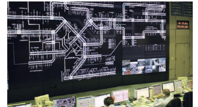
道路管制センター
