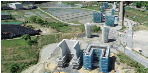
建設中の新名神高速道路 宇治田原第一高架橋
