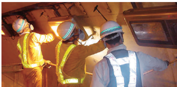
構造物の点検
