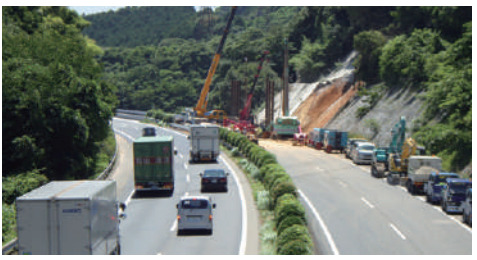
応急復旧の様子
