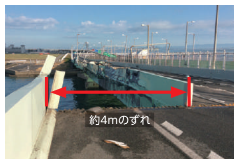
衝突による橋のずれの様子
