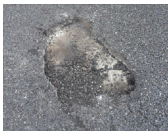
上面 舗装の損傷状況
