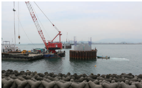
吉野川大橋 工事の様子
