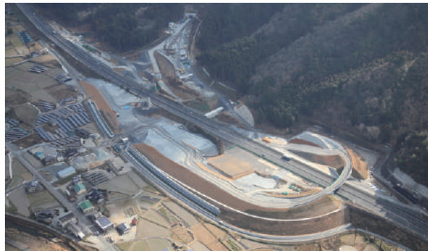
中国自動車道と接続する山崎JCT工事の様子
