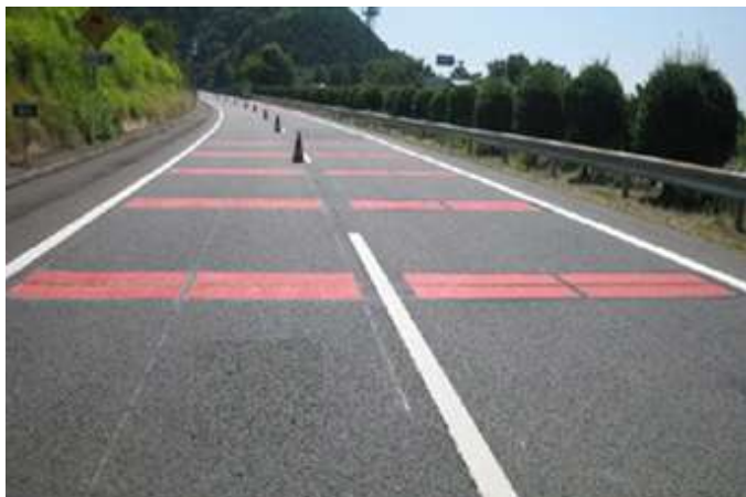
路面の横断している赤色部分が薄層舗装
