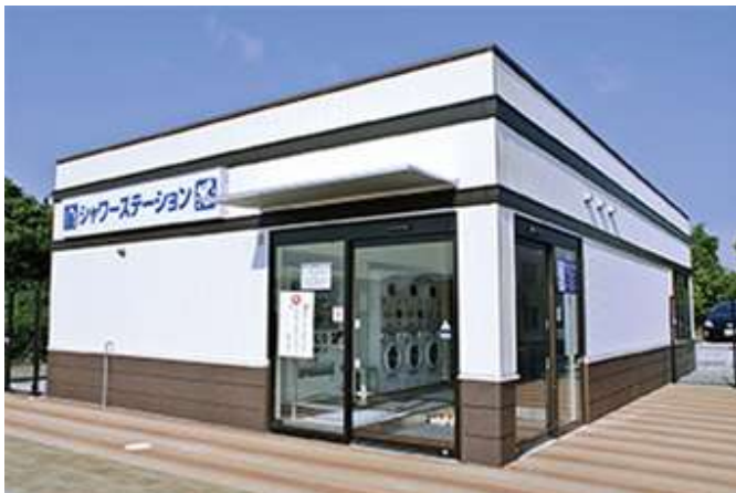
山陽道 淡河PA（上り線）シャワーステーション
