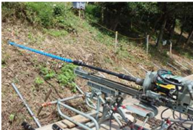
SDPR工法の施工状況
