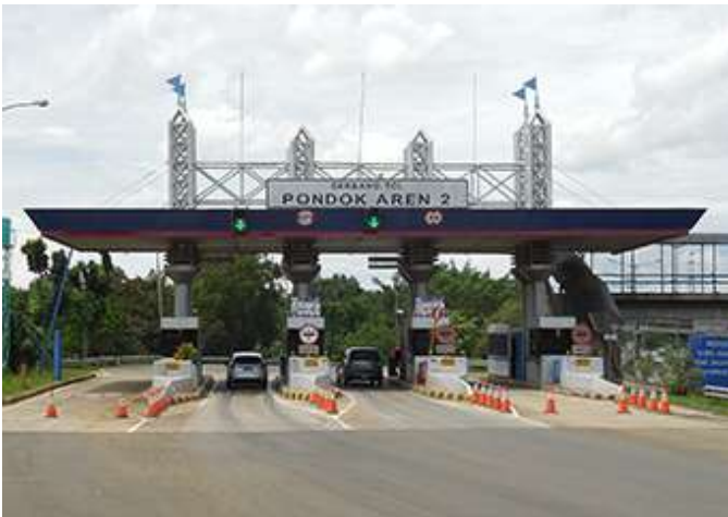
ポンドックアレン料金所
