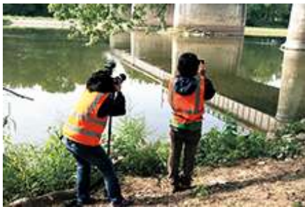
インディアナ州での橋梁点検
