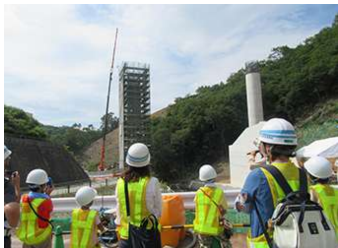
播磨新宮IC工事_建設現場見学
