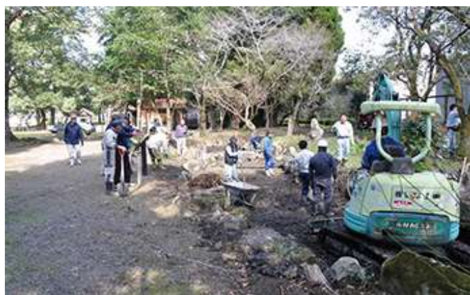
庭園復旧の様子
