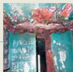
鋼部材の断面欠損
