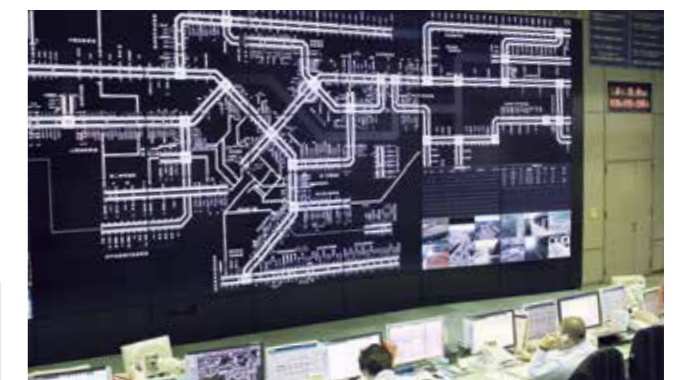
道路管制センター
