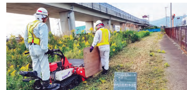
高架下での草刈作業飛散対策の様子
