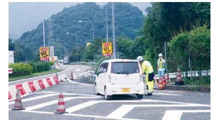
坂本PA下りの緊急開口部で利用許可書を確認
