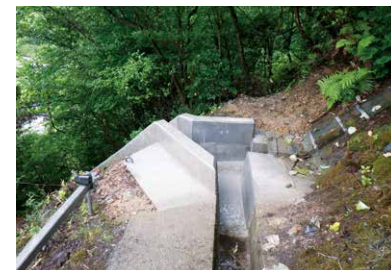
修繕後の集水ますと縦溝
