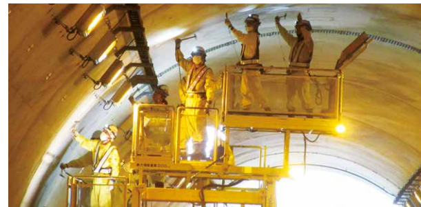
構造物の点検
