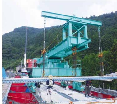
中国自動車道 浦石橋
