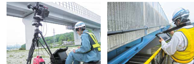
高解像度カメラ(Auto CIMA) タブレットでの点検記録
