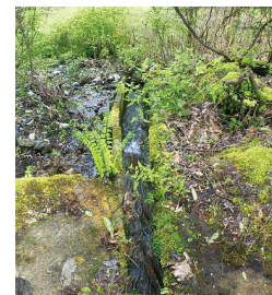
修繕前の縦溝
