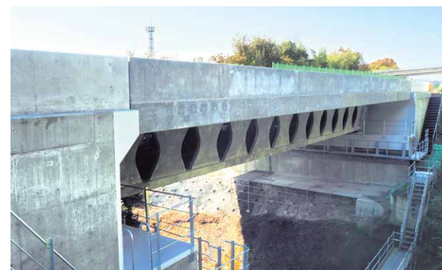
徳島自動車道 別荘谷橋の完成状況
