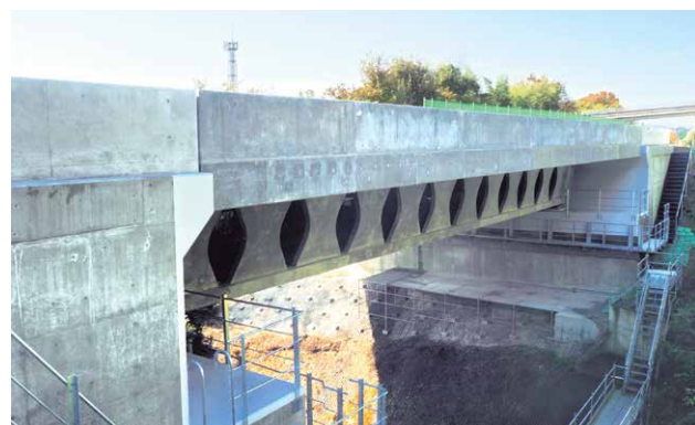
徳島自動車道 別荘谷橋の完成状況
