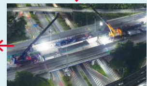
④ 床版・鋼桁架設
