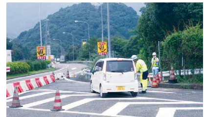
坂本PA下りの緊急開口部で利用許可書を確認
