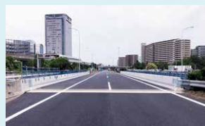
⑥ 工事完了
