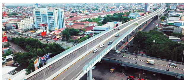
開通した有料道路（インドネシア マカッサル）
