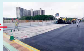
⑤ 舗装施工
