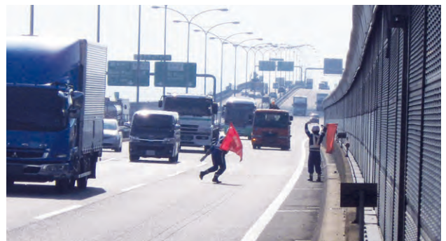
落下物排除の状況
