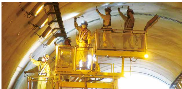
構造物の点検
