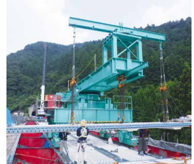
中国自動車道 浦石橋
