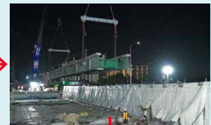
③ 鋼桁撤去
