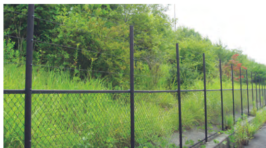
地域性苗木を用いた盛土のり面の樹林化
