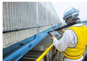
タブレットでの点検記録
