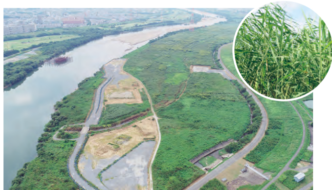
新名神高速道路沿線の淀川では、ヨシの生育環境の保全に取り組んでいます
