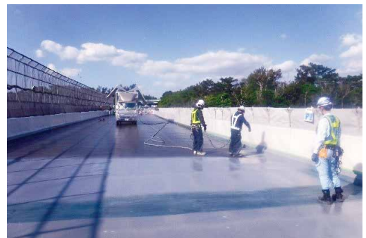
沖縄自動車道 福地川橋
