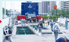
② 床版撤去
