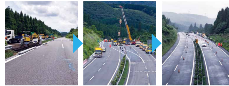
中央分離帯撤去の様子 レーンマーク施工の様子 対面通行規制の完成
