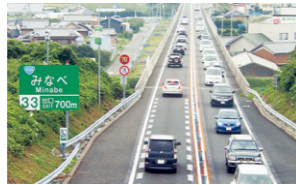
阪和道 印南IC～みなべIC
