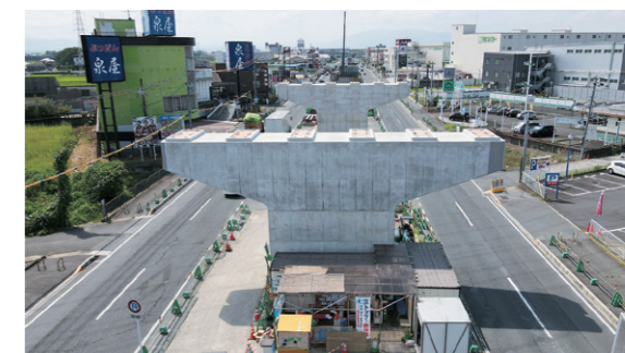
大和北道路 郡山下ツ道JCT付近
