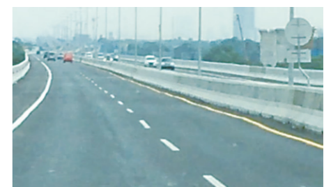
ジャカルタ〜チカンベック高架有料道路(路面の状況)
