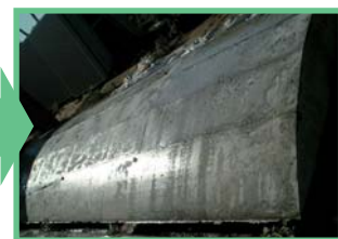
新開発の中流動覆工コンクリート
