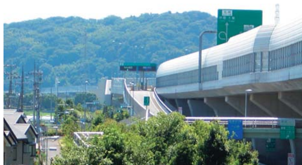
騒音を防止する遮音壁
