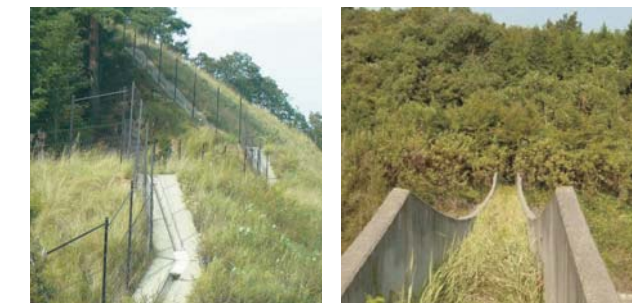
動物侵入防止柵の設置
