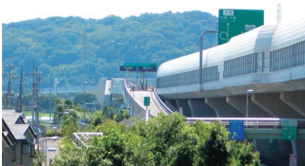
騒音を防止する遮音壁
