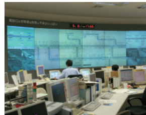
道路管制センター
