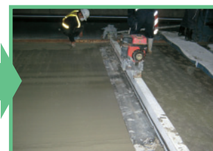
新工法の簡易フィニッシャーによる施工
