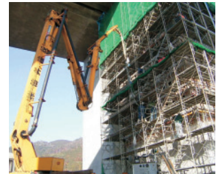
橋脚の耐震補強工事
