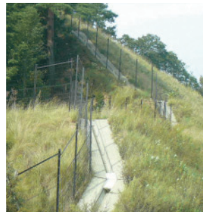
動物侵入防止柵の設置
