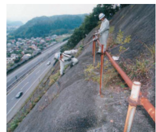
のり面の点検状況
