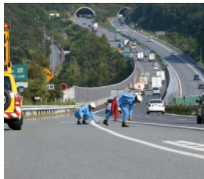
路上障害物の排除
