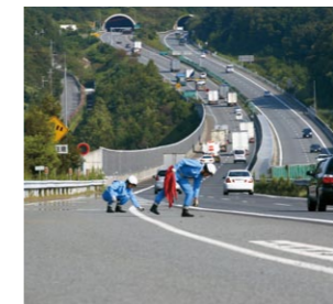
路上障害物の排除
