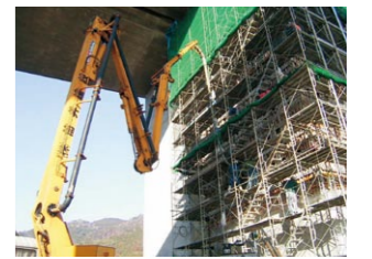
橋脚の耐震補強工事
