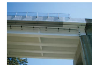
国道と交わる重要交差箇所に繊維シートを貼付しています
