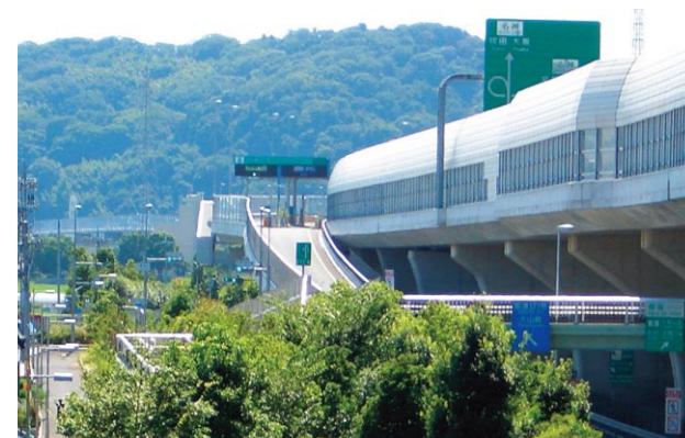
騒音を防止する遮音壁
