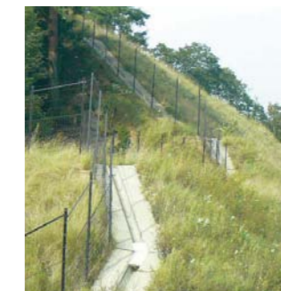
動物侵入防止柵の設置
