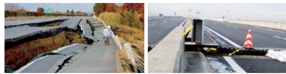
常磐道 水戸～那珂(上り線) 仙台東部道路 仙台港北～仙台東(上下線) 道路本体・路面の崩落等 2カ所 橋梁ジョイント部の損傷 46橋 56カ所
