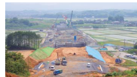
工事が着々と進む盛土区間
