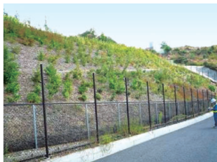
新名神高速道路ののり面に植栽された地域性苗木
