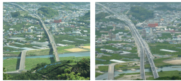
阪和自動車道・有田IC付近(左:施工前、右:完成後)
