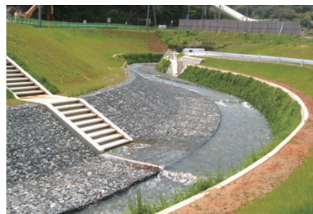
ゲンジボタルの生息環境に配慮した福岡県苅田町の殿川
