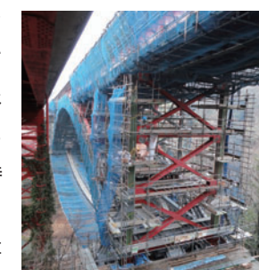
橋脚の耐震補強工事
