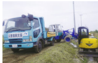
山元町での農地復旧作業の様子
