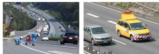
路上障害物の排除
