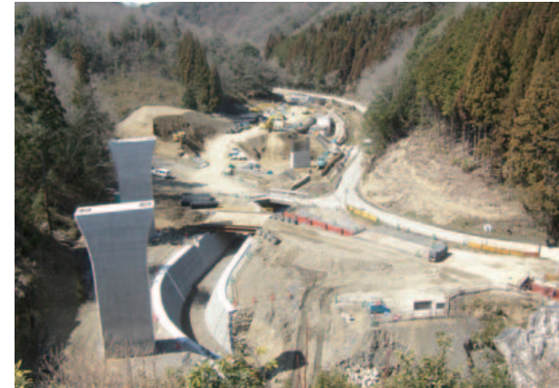
建設中の新名神高速道路(兵庫県猪名川町)
