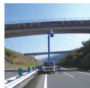
高所作業車による点検作業
