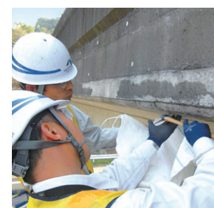
目視での点検
