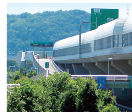
騒音を防止する遮音壁
