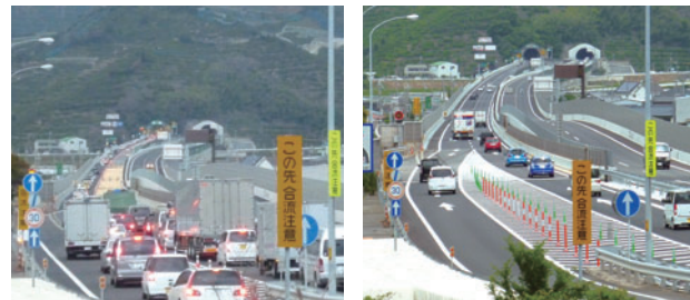
阪和自動車道・有田IC付近(左:施工前、右:完成後)
