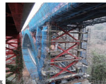
橋脚の耐震補強工事
