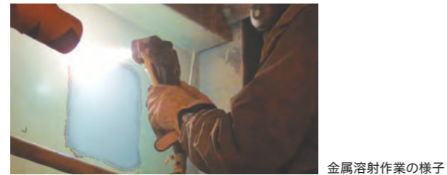
金属溶射作業の様子
