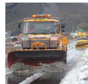
土木維持管理
