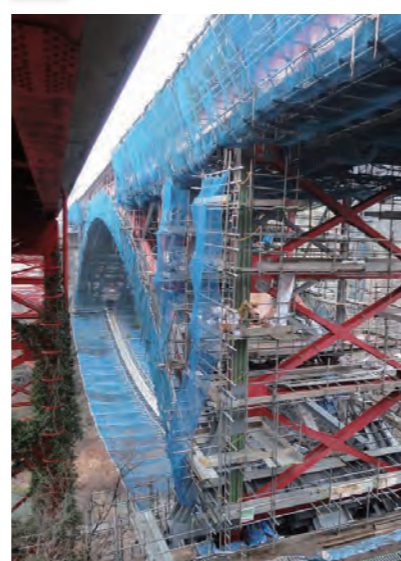
耐震補強工事を計画的に実施しています
