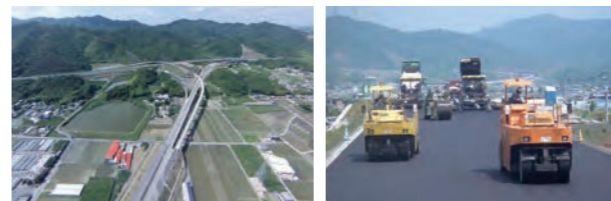
鳴門JCT施工状況 舗装施工状況
