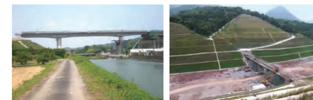
伊呂波川高架橋施工状況 切土施工状況
