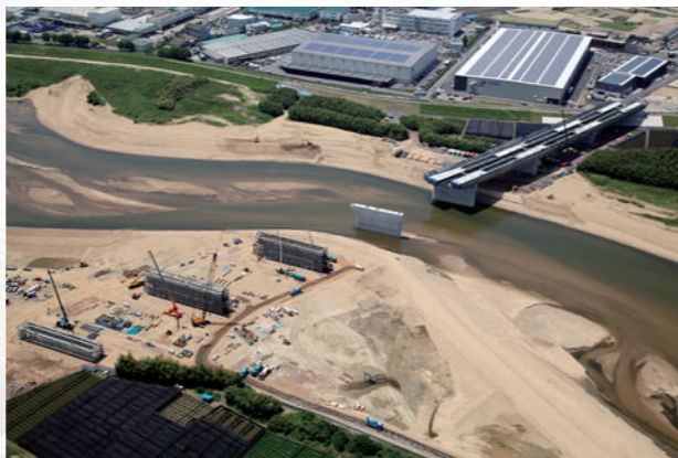
4 工事中の木津川橋
