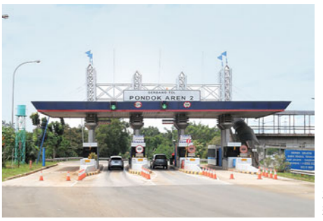
ポンドックアレン料金所
