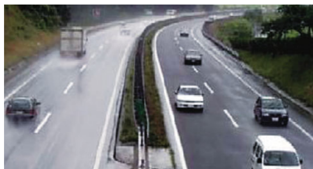
雨天時の走行安全性の向上(向かって右側の車線が高機能舗装)
