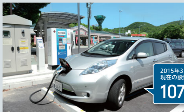
次世代自動車用急速充電設備(中国自動車道 西宮名塩SA 下り線)
