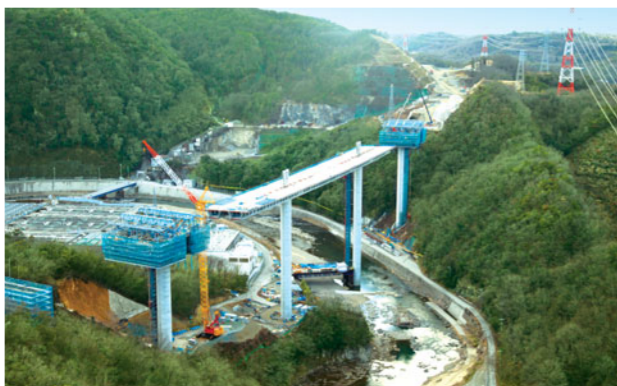
1 工事中の武庫川橋
