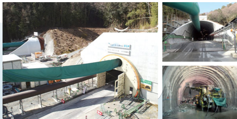
2 工事中の箕面トンネル
