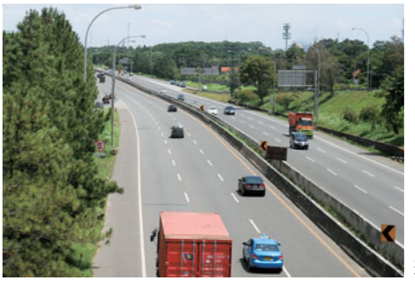
ピンタロー スルボン道路全景
