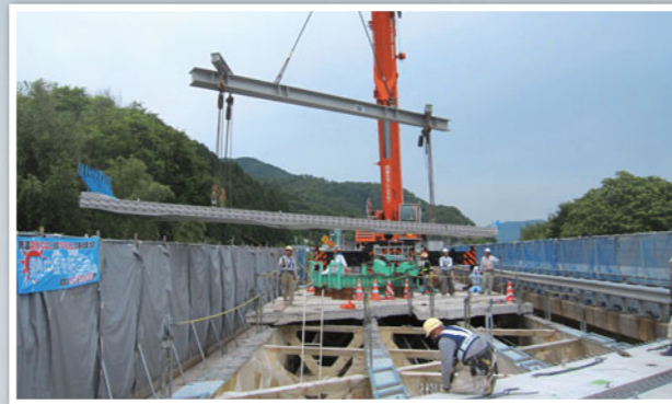
プレキャストPC床版への取り替え工事
