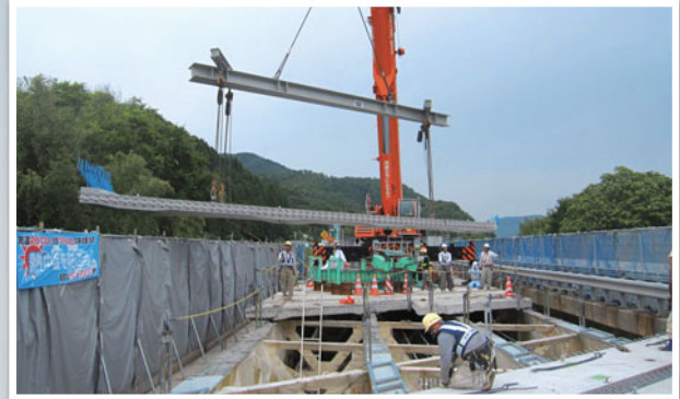
プレキャストPC床版への取り替え工事
