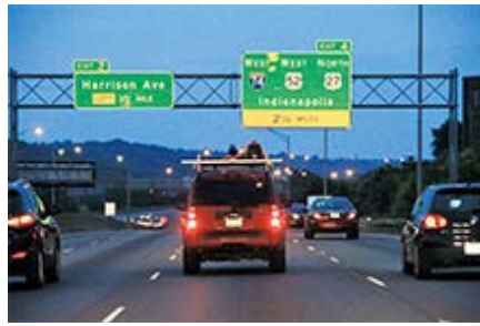
オハイオ州道路橋 車両による夜間点検
