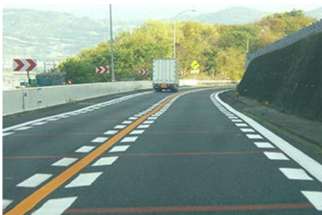
路面を横断している赤色の線が薄層舗装
