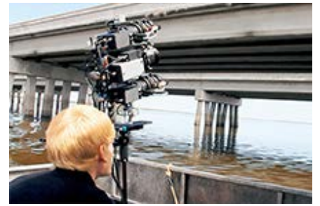
セントラル・フロリダ大学との共同研究に基づくフロリダ州道路橋の点検
