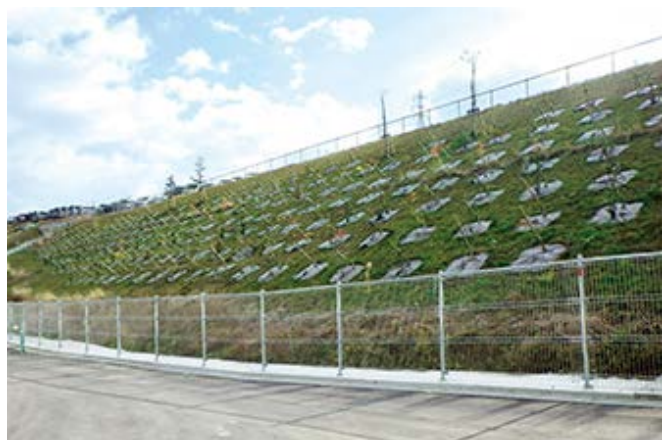
のり面の樹林化
