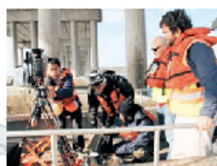
メリーランド州 道路橋の点検
