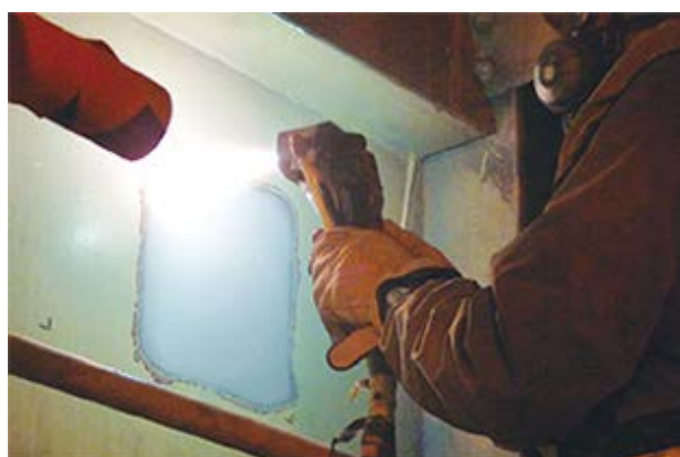
金属溶射作業の様子
