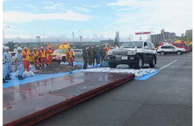
修正した段差を走行する車両
