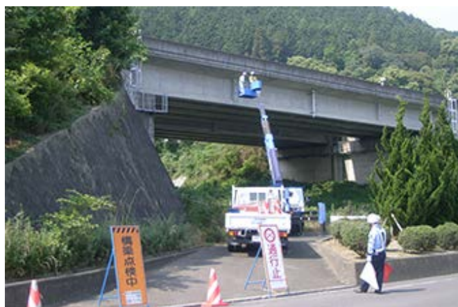
橋梁点検業務
