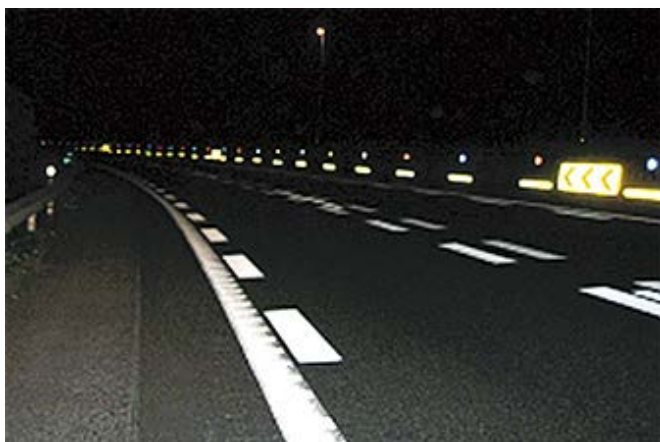
高輝度(凹凸)レーンマーク
