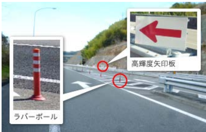
本線合流部の例(16カ所の施工例)
