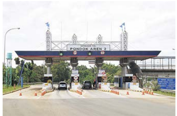
ポンドックアレン料金所
