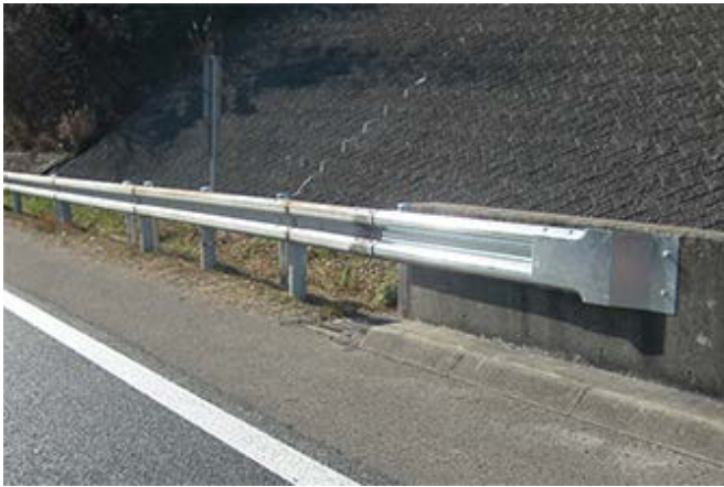
ガードレールの連続化の施工例
