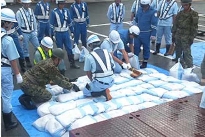
土のうによる段差修正
