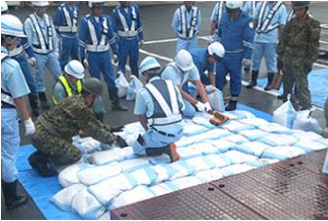
土のうによる段差修正
