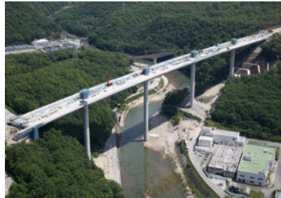
新名神 武庫川橋の建設状況
