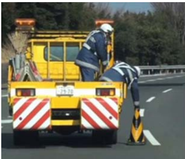
導入前（手作業での設置）
