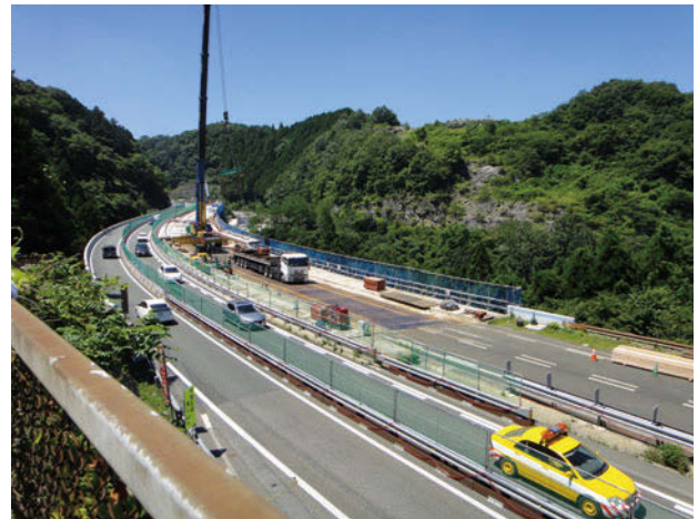
床版の取替工事とそれに伴う対面交通規制
