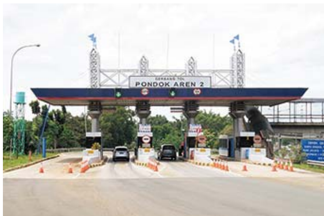
ポンドックアレン料金所
