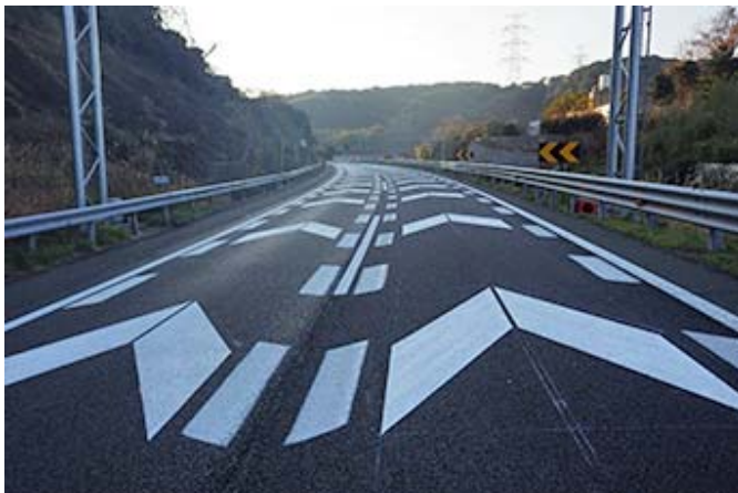
矢羽板や路面標示の施工例
