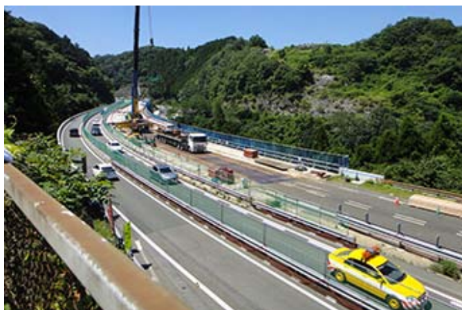
大規模更新・大規模修繕の様子
