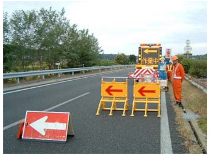
作業ヤードに設置した「とまるくん」
