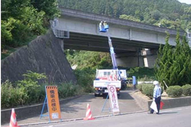
橋梁点検業務
