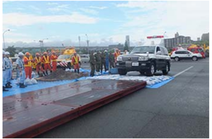
修正した段差を走行する車両
