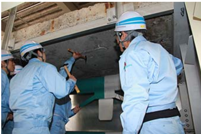
実構造物を活用した打音点検
