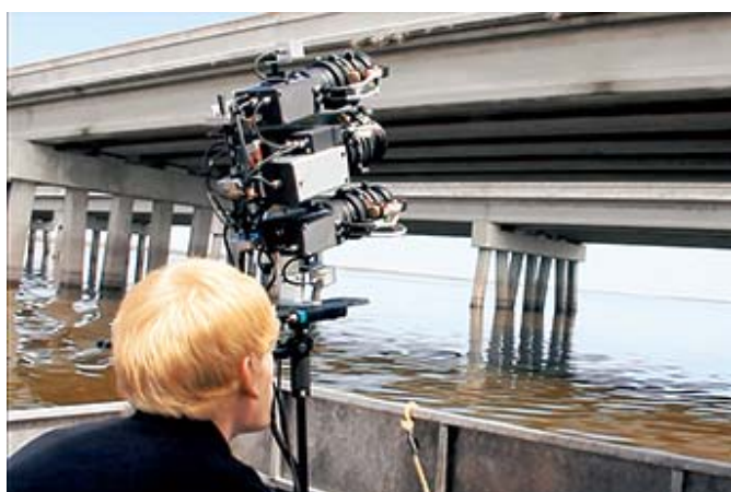
セントラル・フロリダ大学との共同研究に基づく フロリダ州道路橋の点検
