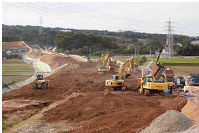
自工区および他の建設工事で発生した土砂を受け入れ、利用
