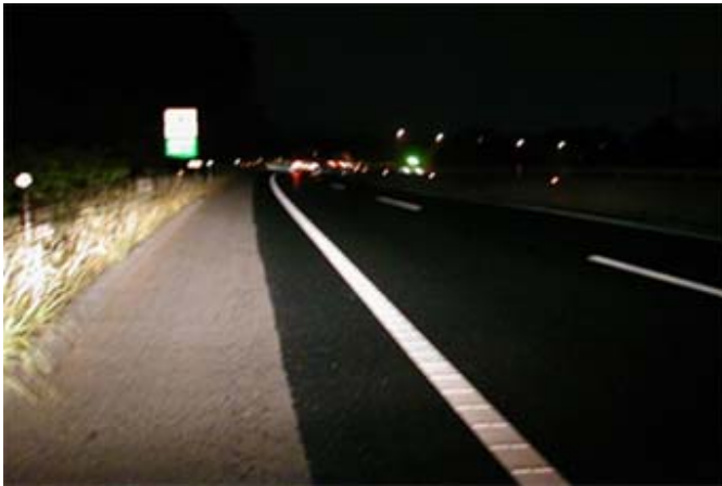
高輝度（凹凸）レーンマーク
