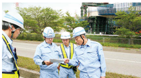
社長(右端)による現場視察
