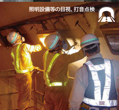
橋梁点検車からの目視、打音点検
