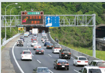
渋滞が頻発している 中国自動車道(宝塚 西トンネル付近)
