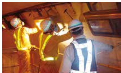
道路や設備等の維持管理
