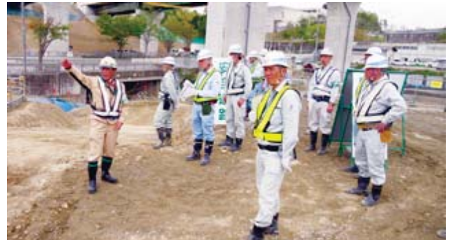
受発注者で実施する安全パトロールの様子
