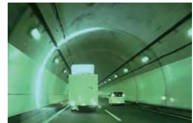
撮影の状況(赤外線照明による撮影を行うことで、お客さまの運転への影響はありません)
