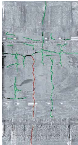
トンネル壁面画像の自動ひび割れ抽出状況
