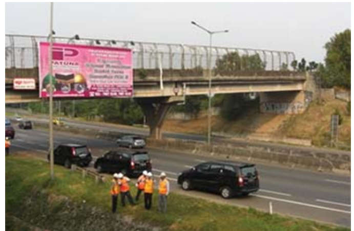
BSD道路全景
