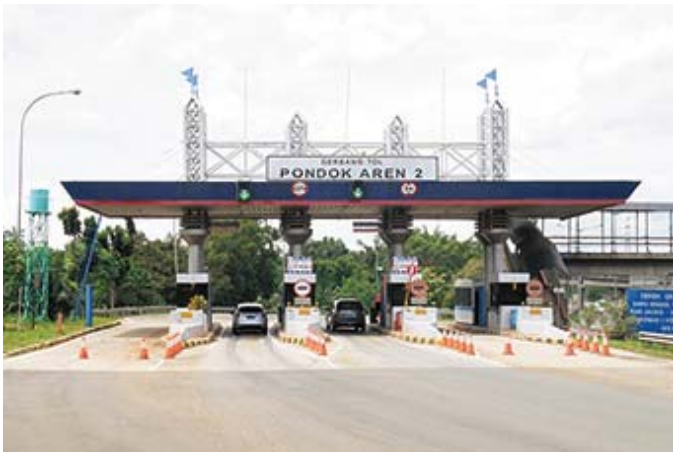
ポンドックアレン料金所
