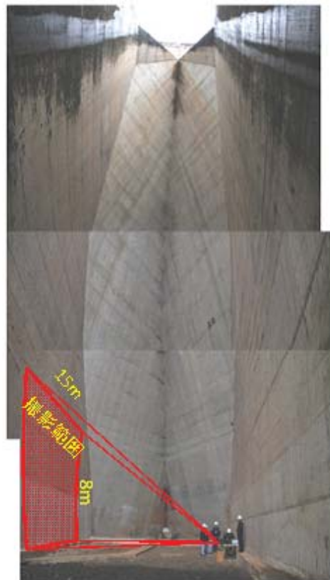
イタイプダム調査状況
