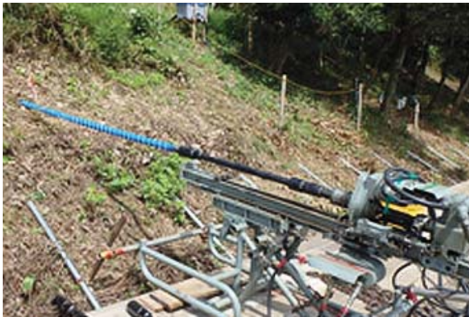
SDPR工法の施工状況
