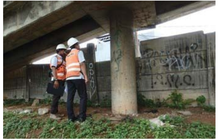
橋梁日常点検
