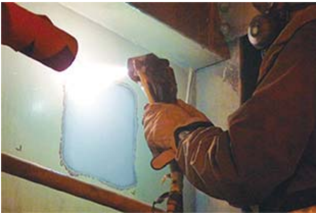
金属溶射作業の様子
