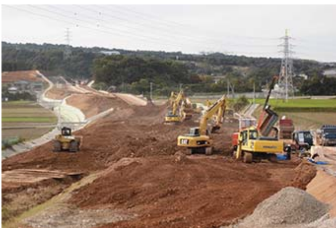
自工区および他の建設工事で発生した土砂を受け入れ、利用
