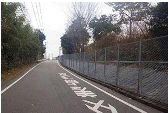
シカ侵入対策（フェンスの嵩上げ）
