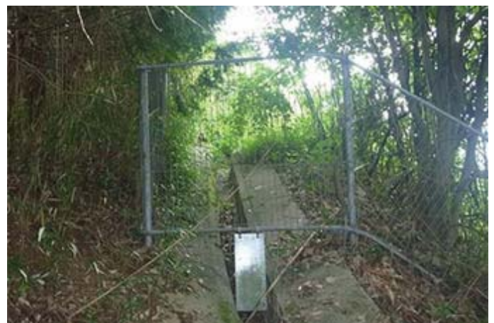
小中型動物侵入対策（排水溝の閉塞）
