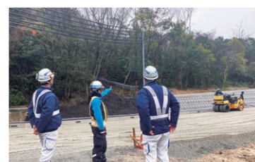
支障移転の現場打合せの様子
