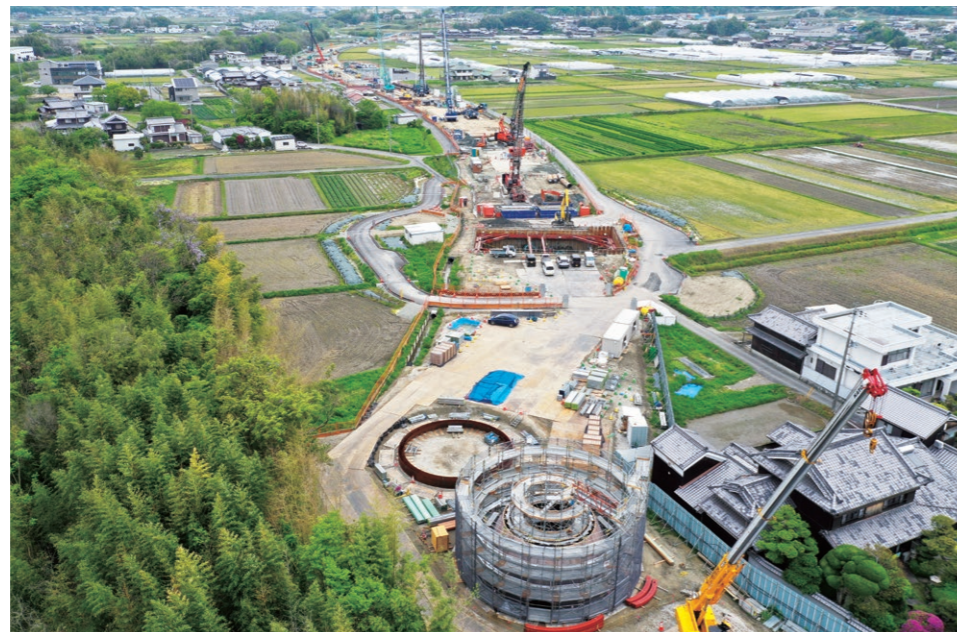
神戸西バイパス 第四平野西高架橋他1橋下部工工事
