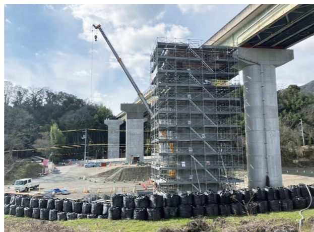
徳島道 脇町IC～美馬IC 脇大谷川橋下部工工事
