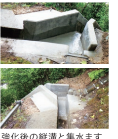
強化後の縦溝と集水ます
