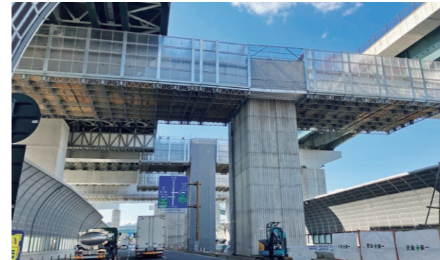
淀川左岸線延伸部 門真高架橋上部工工事
