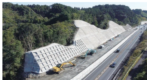
東九州道 宮崎西IC～清武IC 切土による拡幅
