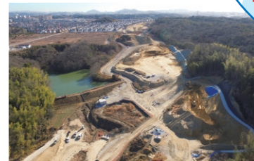
神戸西バイパス 樋谷工事
