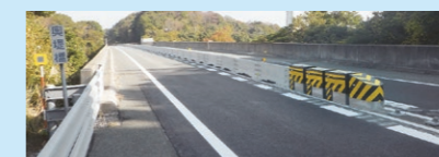
センターブロック
