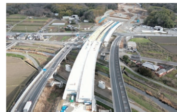
神戸西バイパス 菅野高架橋上部工工事
