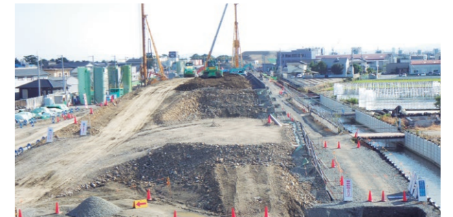
建設発生土の受け入れ
