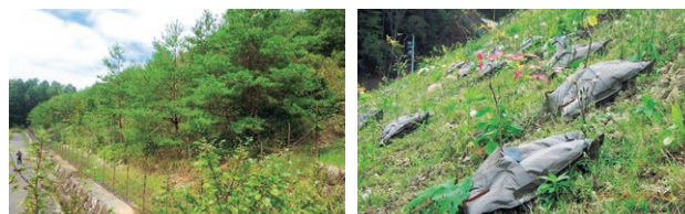
(上) 生育中の地域性苗木 (左) 開通後13年経過し地域性苗木が樹林化した高速道路ののり面 (新名神高速道路 信楽IC付近) (右) 地域性苗木の植栽パック
