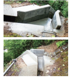
強化後の縦溝と集水ます
