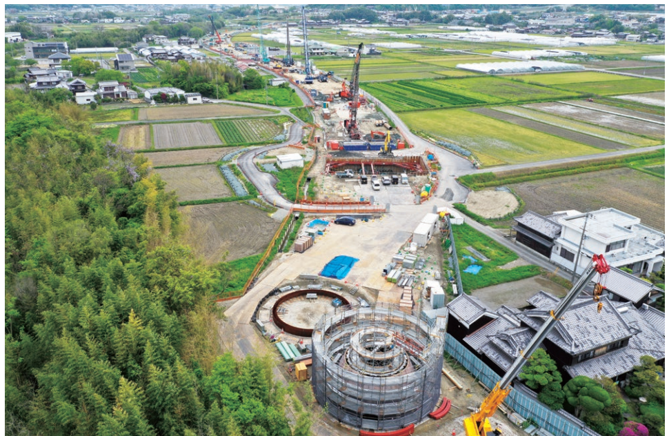
神戸西バイパス 第四平野西高架橋他1橋下部工工事
