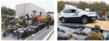
グループ会社や関係機関との合同による段差復旧訓練
