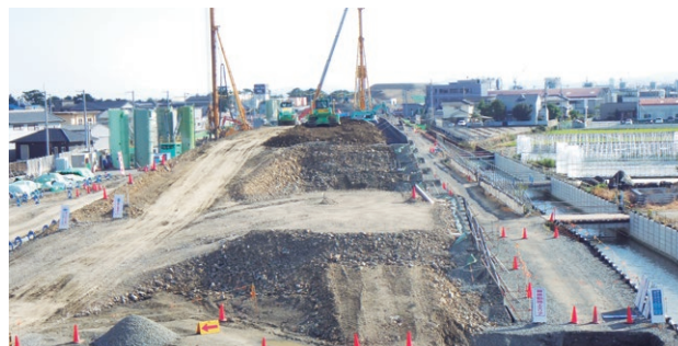
建設発生土の受け入れ
