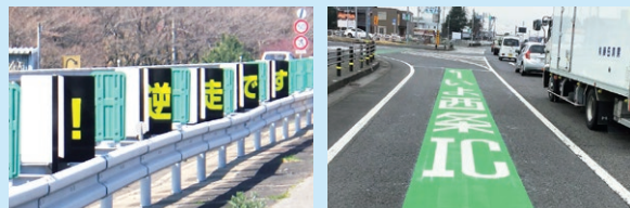
(左) 逆走車両に対する防眩板応用注意喚起 (右) 一般道接続部のカラー舗装 (逆走・誤進入防止)
