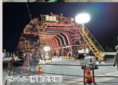
セントルによる覆工コンクリートの打設(内巻補強工)
