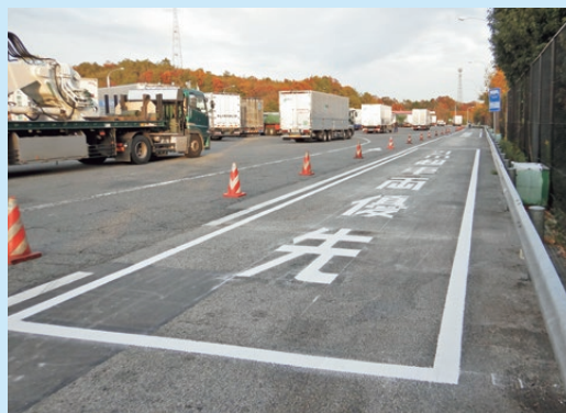
山陽道 三木SA (上) ダブル連結トラックマス整備状況
