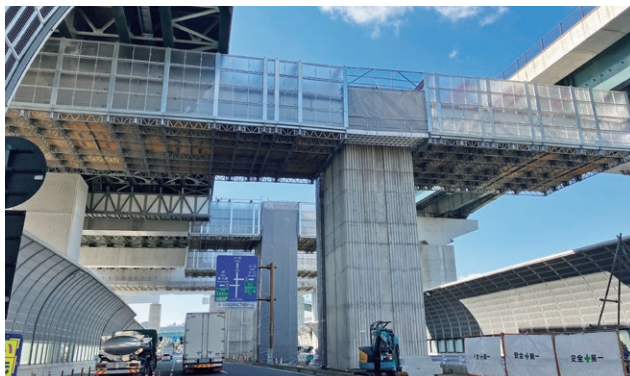
淀川左岸線延伸部 門真高架橋上部工工事
