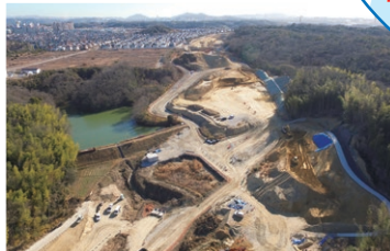
神戸西バイパス 樋谷工事
