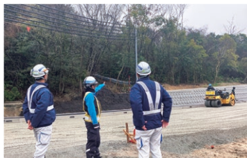
支障移転の現場打合せの様子
