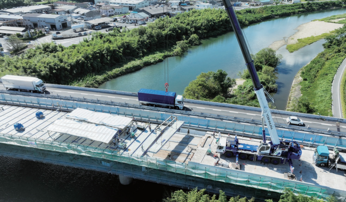
中国道(山口)CT-美祿東)CT) 床版取替工事
