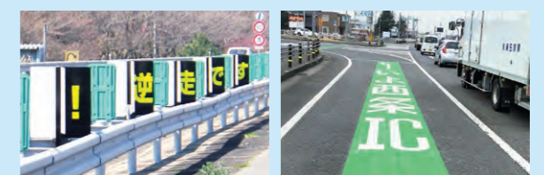
(左) 逆走車両に対する防眩板応用注意喚起 (右) 一般道接続部のカラー舗装(逆走・誤進入防止)
