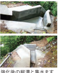
強化後の縦溝と集水ます
