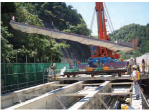
プレストレストコンクリート床版への更新
