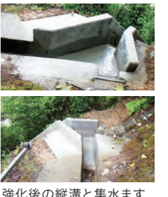
強化後の縦溝と集水ます
