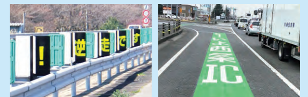
(左) 逆走車両に対する防眩板応用注意喚起 (右) 一般道接続部のカラー舗装(逆走・誤進入防止)
