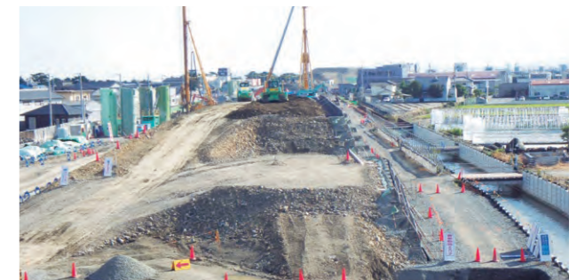
建設発生土の受け入れ
