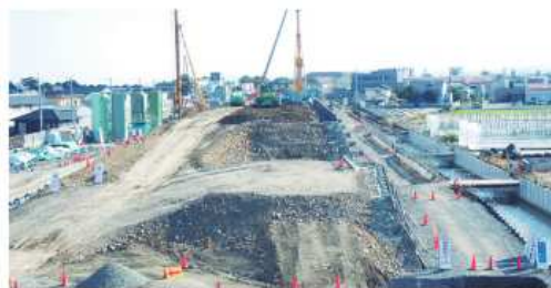
ほかの建設工事等で発生した土砂を受け入れ、利用しています
